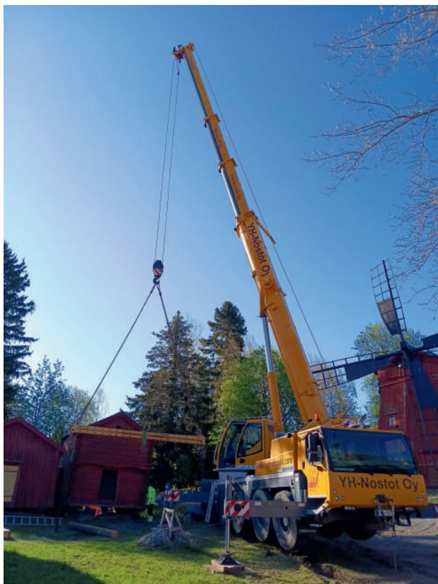
Spannmålsboden lyftes tillfälligt bort med lyftkran så att grunden kunde göras högre.
