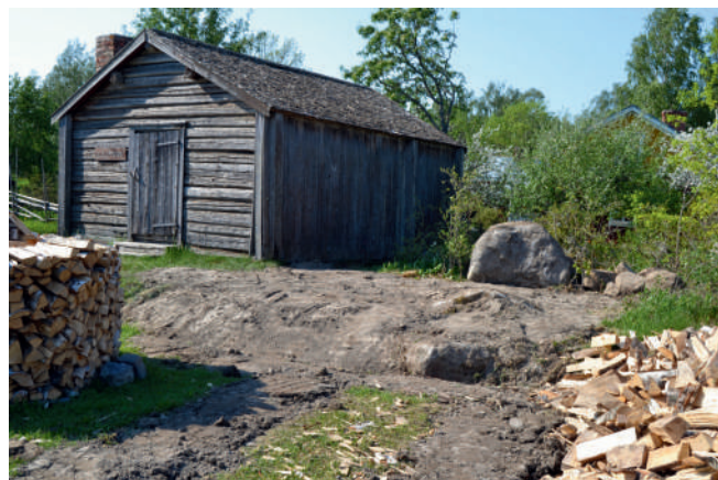
Mycket trädavverkning och markarbeten har utförts 2024.
