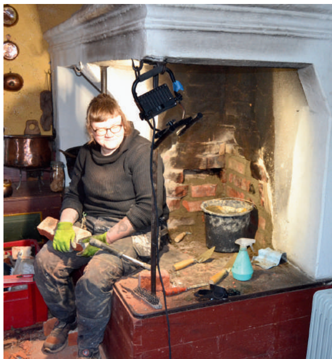
Byggnadsvårdare Saana Lind har restaurerat muren i den öppna spisen i bondstugan under hösten.
