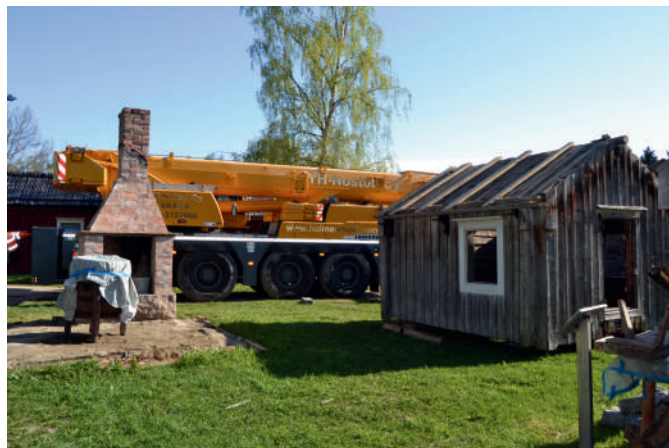
Att lyfta bort kopparslagarens verkstad utan att rasera skorstenen inuti var ett jobb för en riktig lyftkransmästare!
