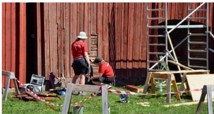
Flera väggar har fått ett nytt lager rödmylla under året. Här byts en del av brädfodringen på loftsraden ut innan målning.
