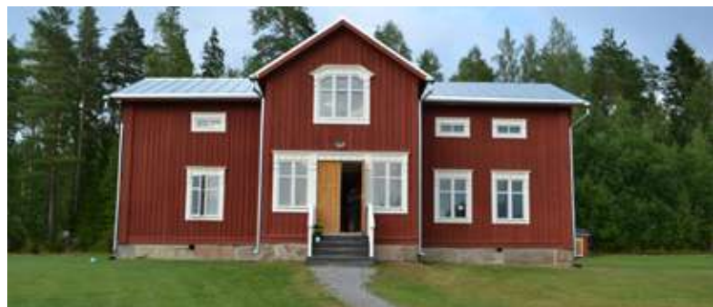
Widgrens hus utvändigt. | Widgrenin talo ulkoa.
