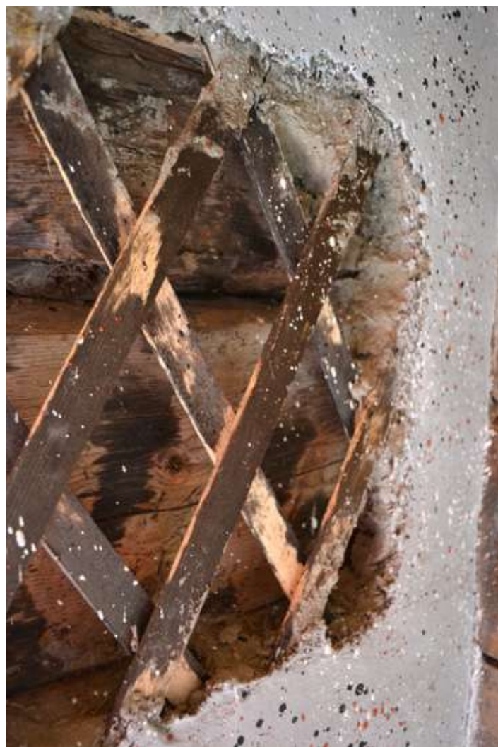
Lerrappningen består av många olika lager. Savirappaus muodostuu monesta eri kerroksesta.
