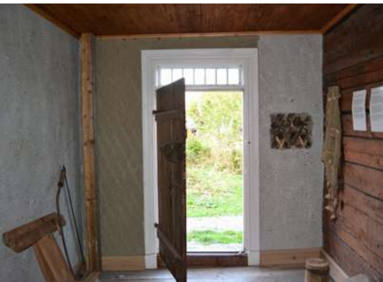
Här syns lerrappningens olika arbetsskeden. Tässä näkyvät savirappauksen eri työvaiheet.
